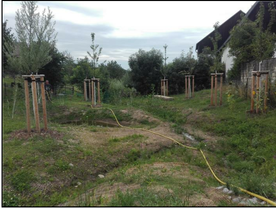
Abb. 4: Nach der Maßnahme: Wiederhergestellter Abschnitt des Borsberger Dorfbaches mit Baumbepflanzung im Gewässerrandstreifen, Blick stromab, 15.08.2019
