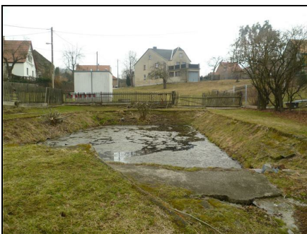
Abb. 1: Vor der Maßnahme: ausgebauter Borsberger Feuerwehrteich im Quellbereich des Borsberger Dorfbachs, 15.03.2011
